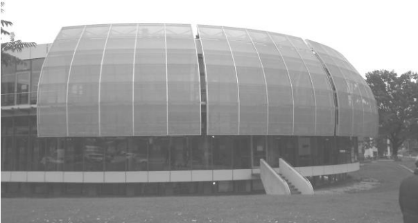
Innovative, dem Sonnenverlauf folgende Verdunklung [Foto: VIB]
